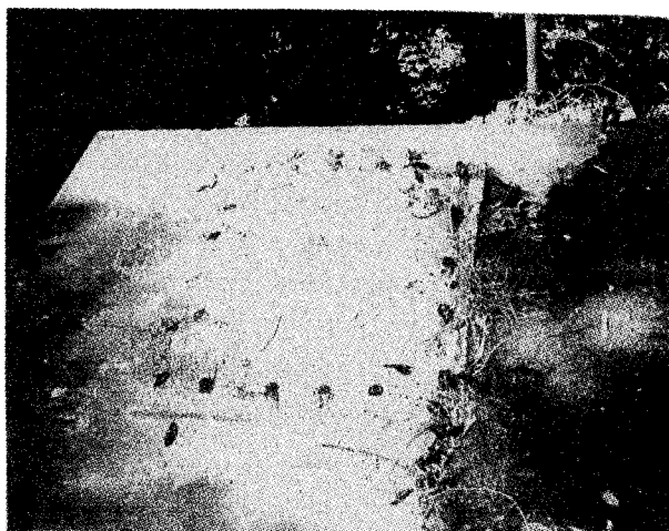
写真一 10 (2) 同上東岸の塔柱基礎の鉄筋遺跡 (筆者撮影)
