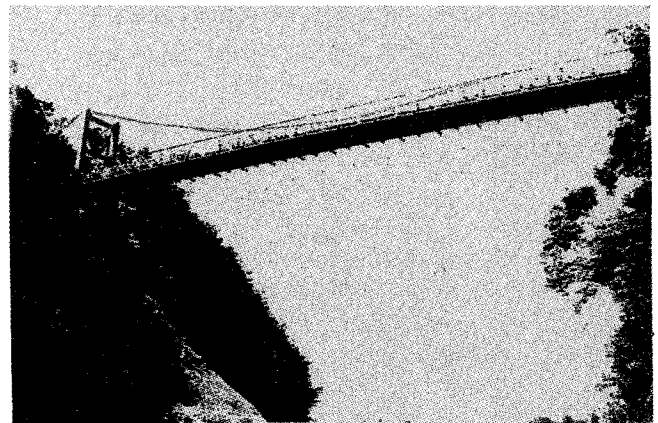
写真一八（1）第11代南原橋（昭和35年3月竣工）東岸から西岸を望む。 9）
