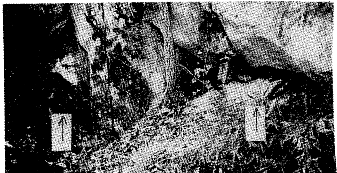
写真—3（1） 天南橋の吊橋アンカレッジ遺跡 （丸鉄棒2本）（筆者撮影）
