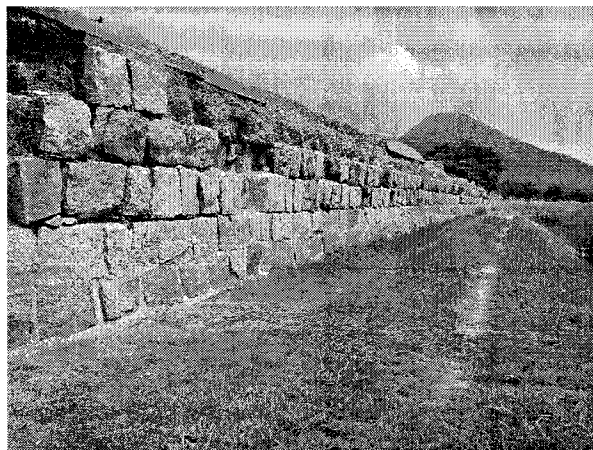
写真-2 第一区第一号干拓堤防 (著者撮影)
