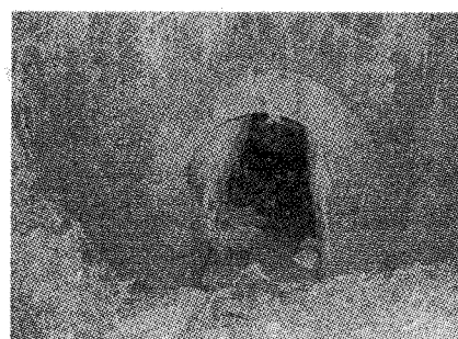
第二境谷川暗渠
