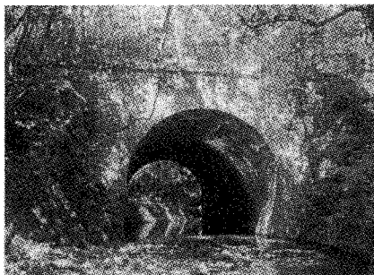
波多第一橋梁
