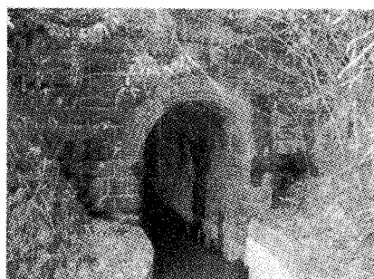
小山ヶ谷川暗渠
