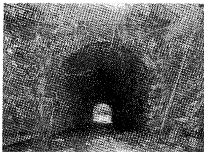
瀬久谷川暗渠
