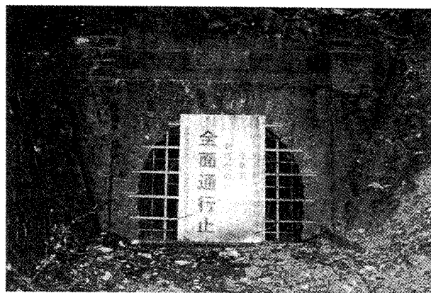
写真－1 千早隧道の坑口（千早側）
