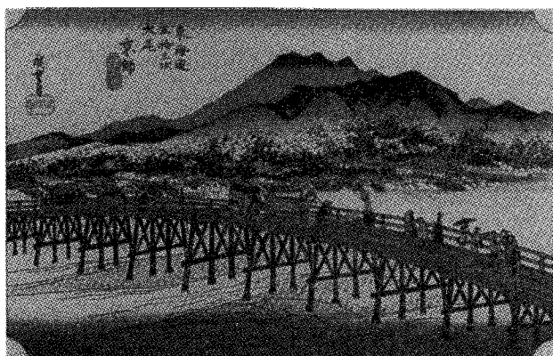
写真-3 三条大橋 15)
