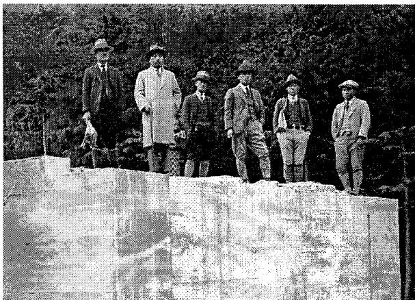
写真-21 昭和7年10月、奥多摩町弁天橋の工事視察に訪れた東京府橋梁課の職員（東京都建設局蔵）
