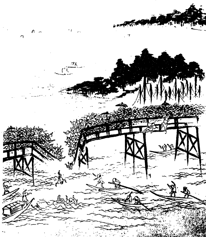
図-1 永代橋の落橋(夢の浮橋『燕石十種』) (1)
