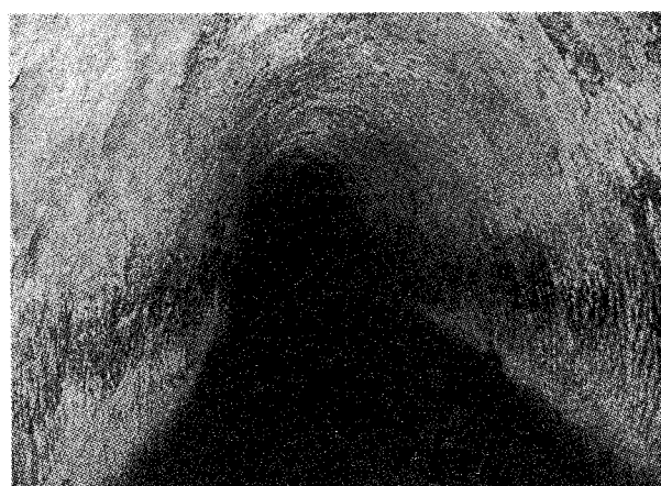
写真-3 滑らかに仕上げられた壁面
