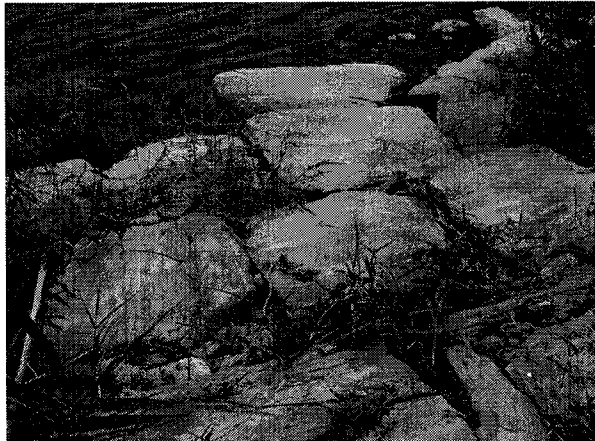
写真-2 堰体を構成する青石(撮影:岩屋, 2005. 7. 17.)
