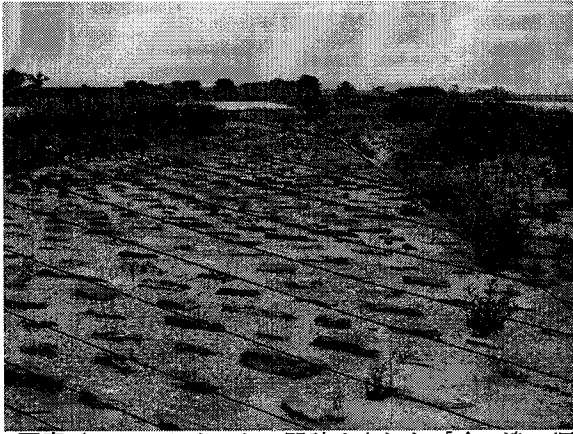
写真-1 コンクリートで間詰めされた「喰い違い堰」 (撮影:岩屋, 2005. 7. 17.)
