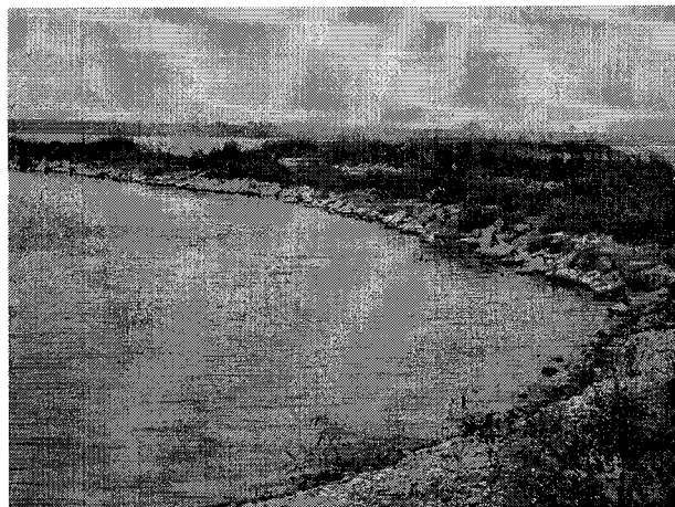
写真-3 巨大な「水刳ね」(撮影:岩屋, 2005. 7. 17.)
