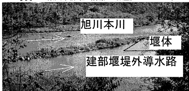
写真-7 旭川建部井堰 (撮影：岩屋，2005. 11. 19.)
