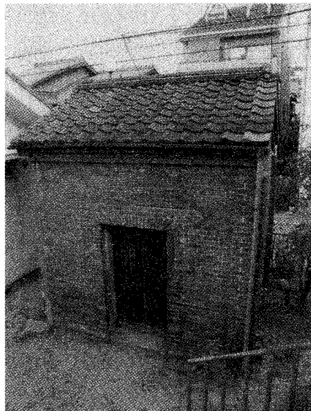
写真-1 稲荷駅ランプ小屋（線路側）
