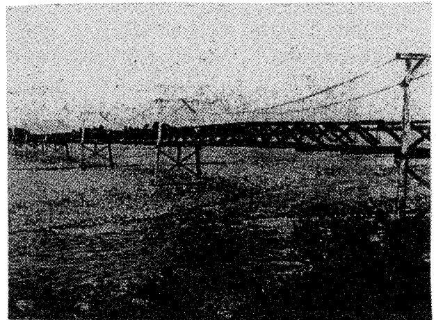
写真-15 大日橋（明治36年2月架設、木鉄混用補剛トラスと斜材付門型塔柱の吊橋） 18)
