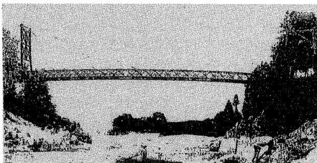
写真一18 天南橋(南原橋9代)明治32年架設、下久堅村と竜丘村立会。(27)
