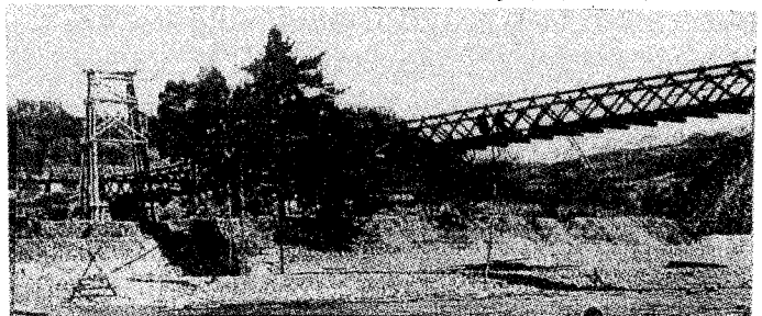
写真—34 万年橋 遠景（明治41年10月竣工）左岸（河野村）より右岸（山吹村）を望む。 41)
