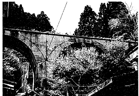
写真3 旧大間線・風間浦陸橋
