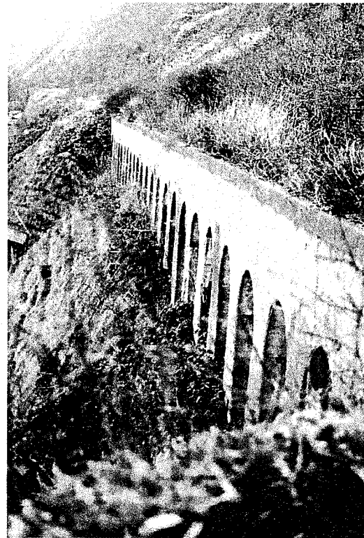
写真6 旧戸井線・瀬田来第二陸橋
