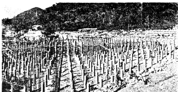
写真-4 工事中の布江調整池 (出典:『発電水力学』, 1932)
