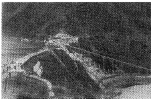
写真-6 運材のためのチェーンコンベア (祖山ダム)
