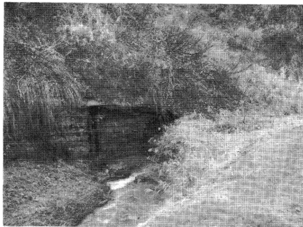
写真-2 下貫木川の河川トンネル入口 (撮影：岩屋, 2004. 12. 4.)
