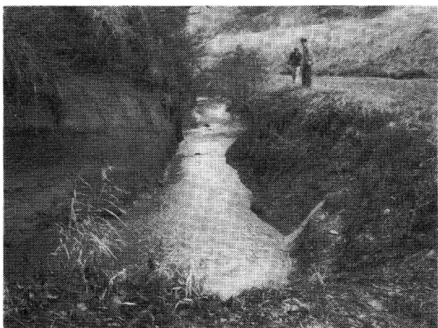
写真-4 下貫木川河川トンネル出口直下の状況 (撮影：岩屋, 2004. 12. 4.)
