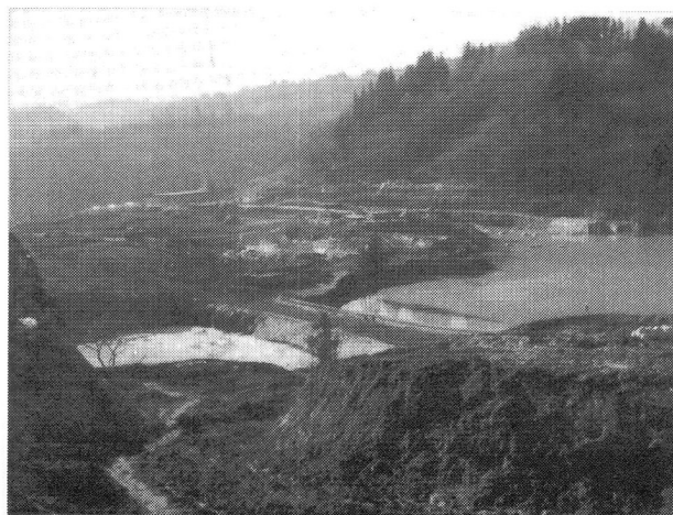
写真-7 芋川東竹沢地区の土砂ダム (撮影：岩屋, 200. 4. 12. 3.)
