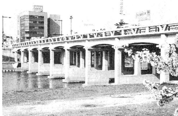
写真-2 橋脚下部のみ補強された例：殿橋（愛知県、矢作川）
