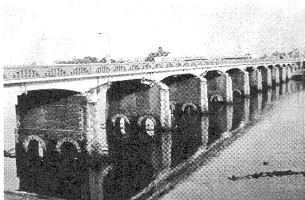
写真-5 橋脚半分が補修された例：山国橋（福岡県、山国川）
