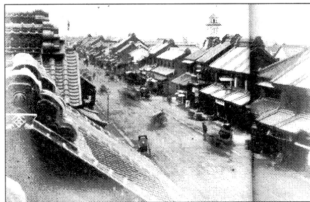
写真3. 日本橋本町通り 25)
