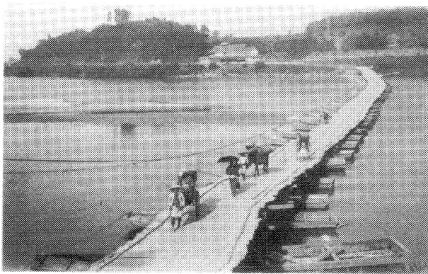
写真2 船橋の例 立ヶ花船橋 文献2) 所載
