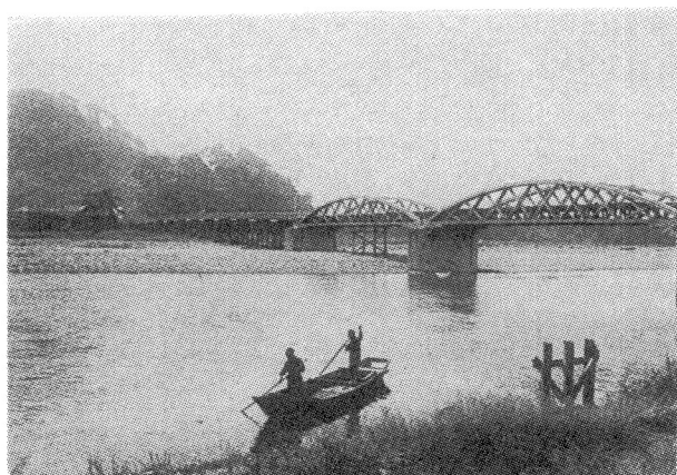
写真－１ 栃木の渡良瀬橋
