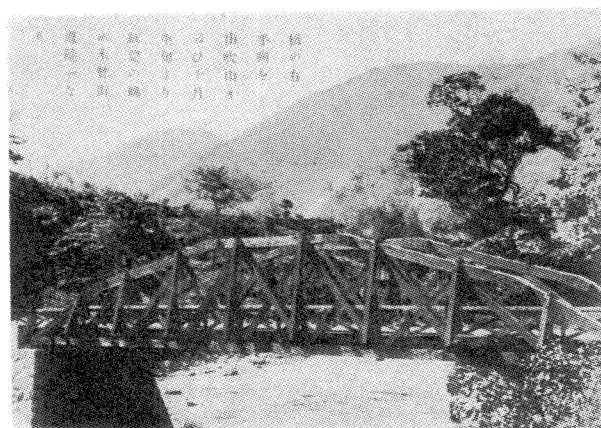
写真－２ 長野の山吹橋
