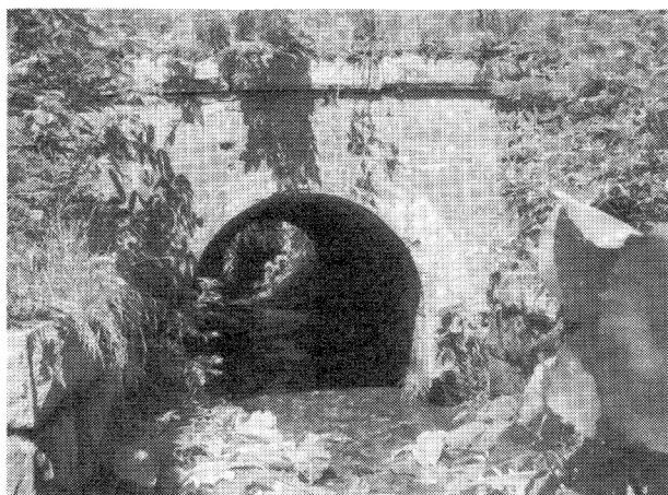
写真5 CN142・二の沢溝橋（第13号拱橋・本線）
