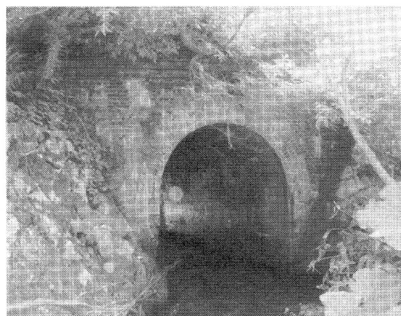
写真3 CN141・バイユルシエベ川溝橋（本線）
