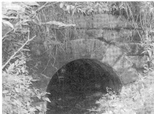
写真6 CN142・二の沢溝橋（第13号拱橋・引込線）
