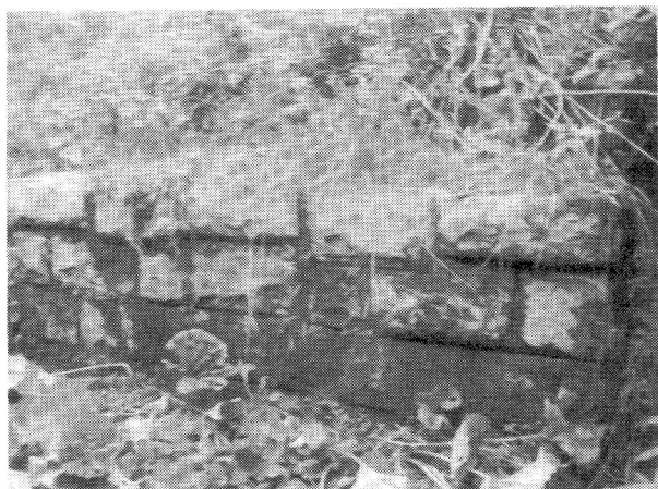
写真7 仮線の橋台と思われる石積み橋台
