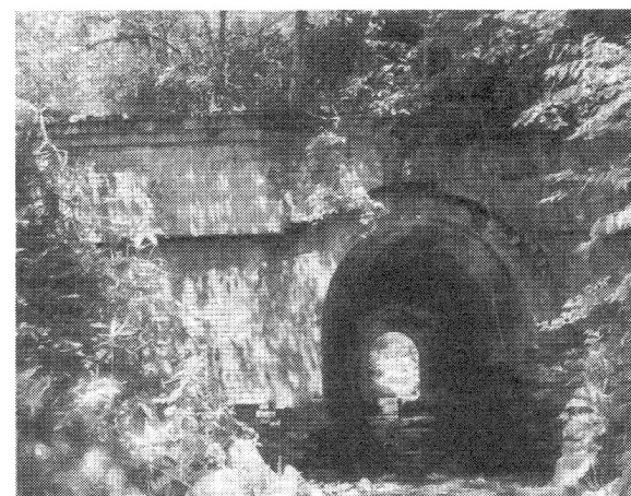
写真4 CN141・バイユルシエベ川溝橋（引込線）
