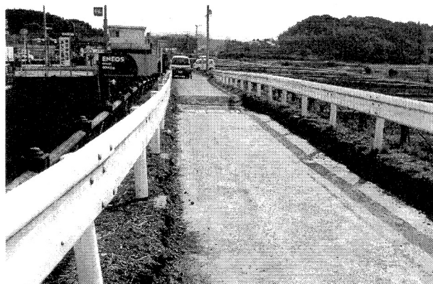
写真－3 調査状況(橋面上舗装撤去)
