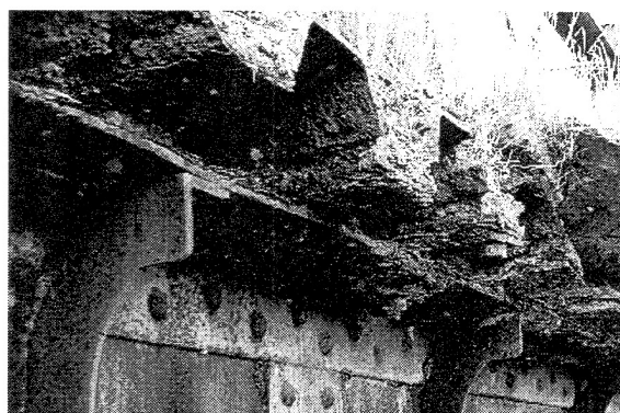
写真－１３ 床版－桁結合部（桁外面）
