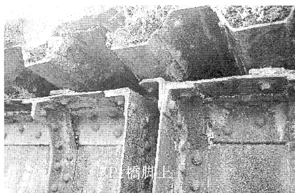
写真－６ P1 橋脚上床版連続部
