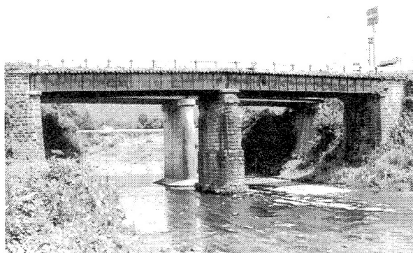
写真-1 明治橋全景
