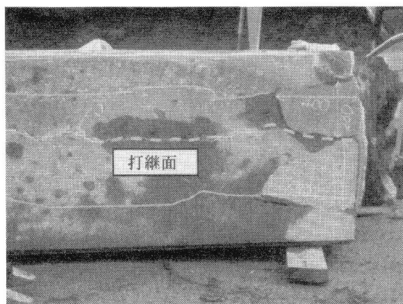
写真-6. 切り出しコンクリートの状況
