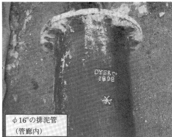
写真-3. 鉄管の鋳出し（D. Y. Stewart 社）
