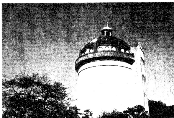
写真－1 大谷口配水塔(撮影:窪田陽一、2004)
