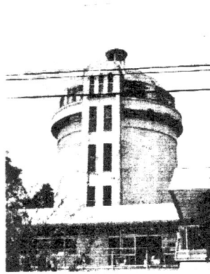
写真-3 野方配水塔 (撮影：増田敏行 2004)
