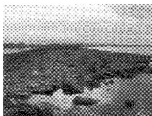
写真-1 第十堰（上堰）
