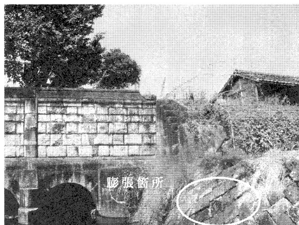
写真-12 取り付け護岸の状況
