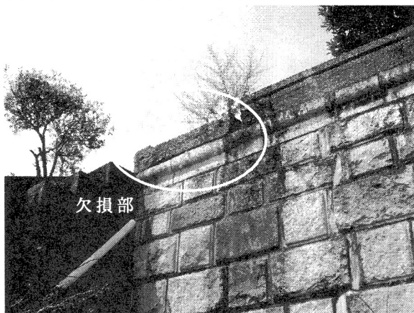
写真－6 郡築二番町樋門面壁、波受け壁の状況
