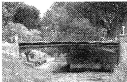
写真-6 ヴァレット通り歩道橋
