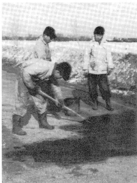
図10 補修試験工法の実施 注6
