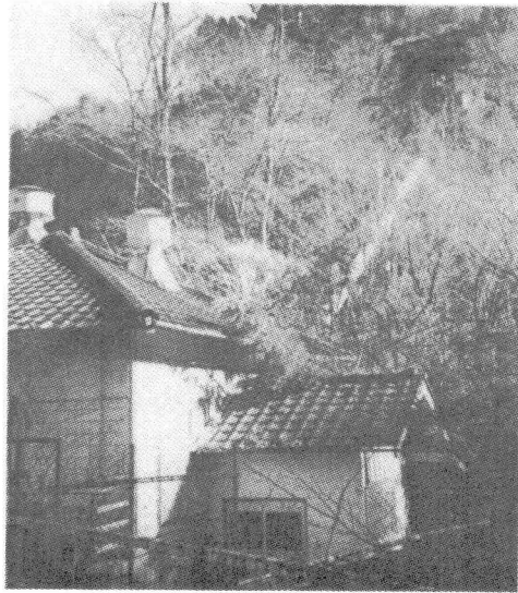
図3 多治見電燈第二小滝発電所 (撮影：茂吉、2001.8.16)
