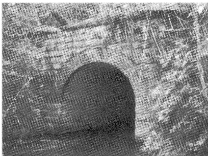
写真-17 酔之尾川暗渠（上流）
