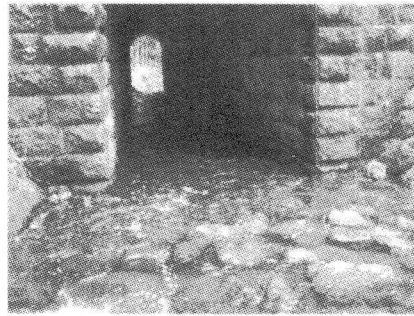
写真-8 会田川暗渠の敷石
