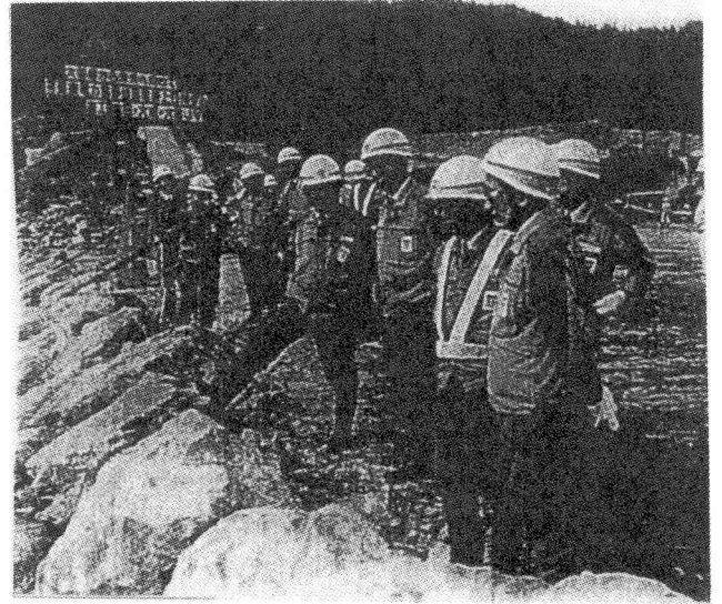
葛野川発電所ダム(平成8年)
