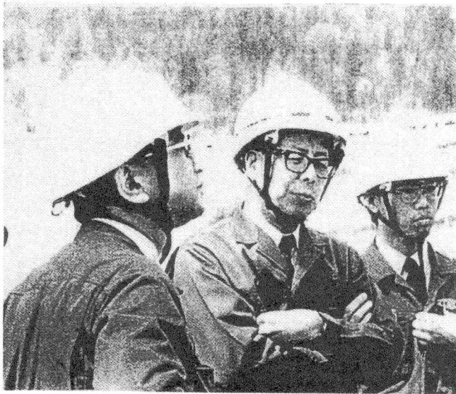
今市発電所上部ダム(昭61年)
