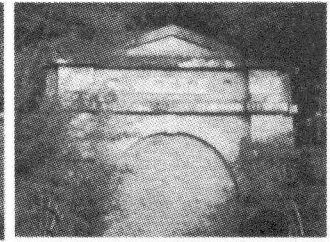
図-11. 烏原ダム上流の放水門(著者 2003.10)
