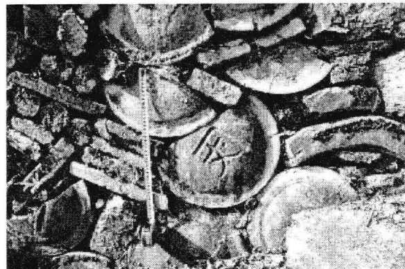
写真-3 エンゴロを加工して構築された窯垣の例 (撮影: 筆者 2003)
