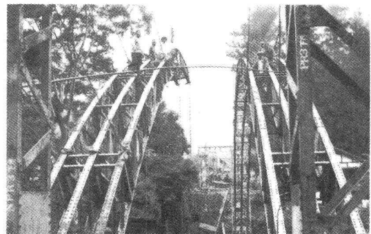
写真15 氷川大橋メラン材架設(東京都建設局蔵)
