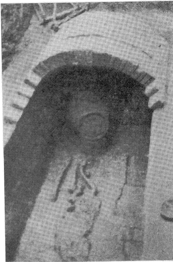
写真一七 洛陽焼溝 M49号墓 “楔形小磚”による“横列”積み真正アーチ構造 (文献 28) より)
