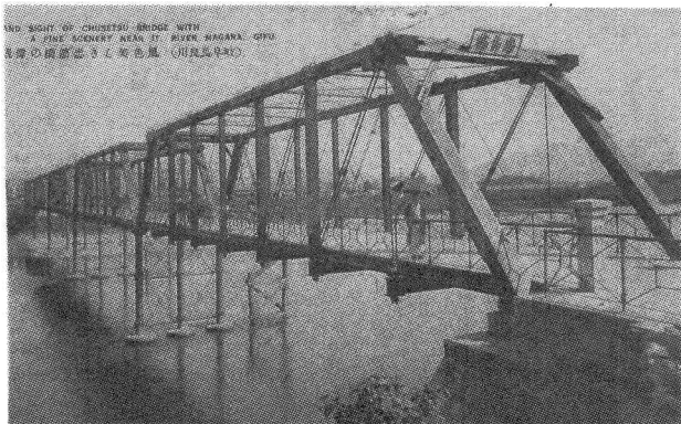
写真-12 岐阜の忠節橋
