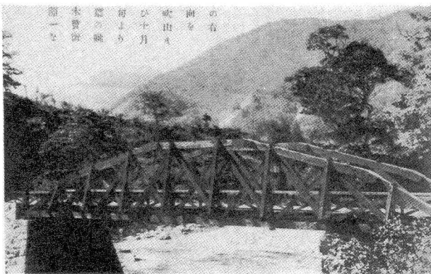
写真-22 長野の山吹橋
