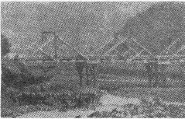
写真-1 山梨の波木井の橋
