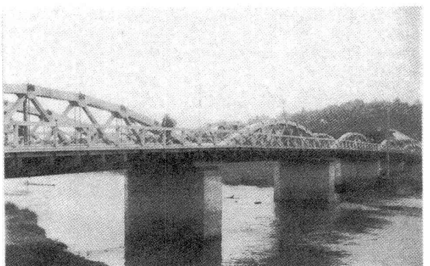
写真-21 福井の九十九橋
