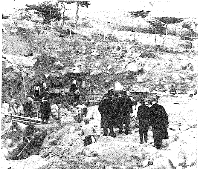
写真 1 昭和初期の六麓荘造成現場（写真提供細野組）
