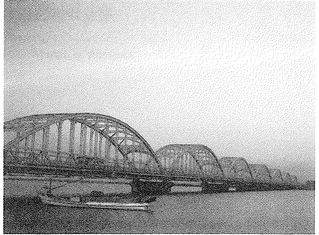
写真-4 伊勢大橋(三重県) [撮影：福井, 2003. 3]
