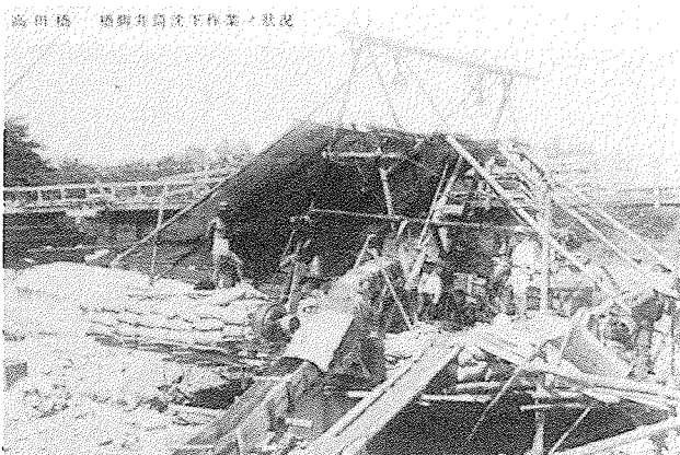
写真-27 施工中の高田橋(その1)
