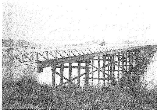
写真-4 神通新大橋(連隊橋)
