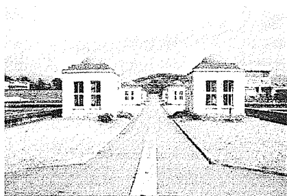
図—4 送水軸に対称配置された浄水井上屋群及び 緩速濾過池(筆者撮影:2001.8.21)
