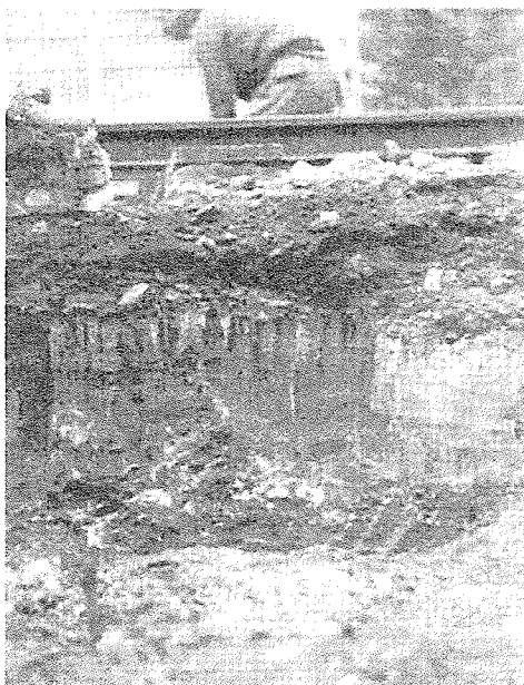
図5 掘削され露出した路盤 注8
