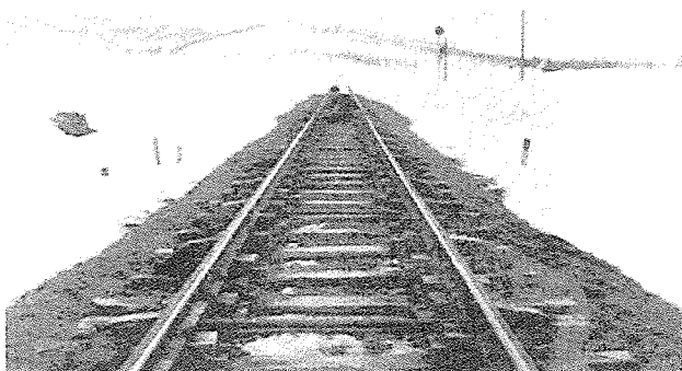
図1 挟み木挿入後の軌道 ③
