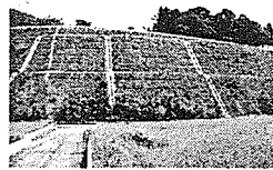
鹿児島県宮之城町 のり面
