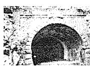
福岡県 仲哀隧道
