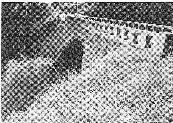
写真1 大谷橋(平成14年8月撮影)
