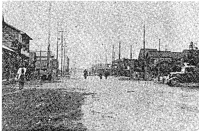
写真-1 施工完了時の島田第一土地区画整理組合 40)
