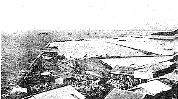
図 9 (上)弁天砲台(工事前) (中)新市街地(工事後) (下)山背泊方面(現函館漁港周辺)(1897.10.1) 注6
