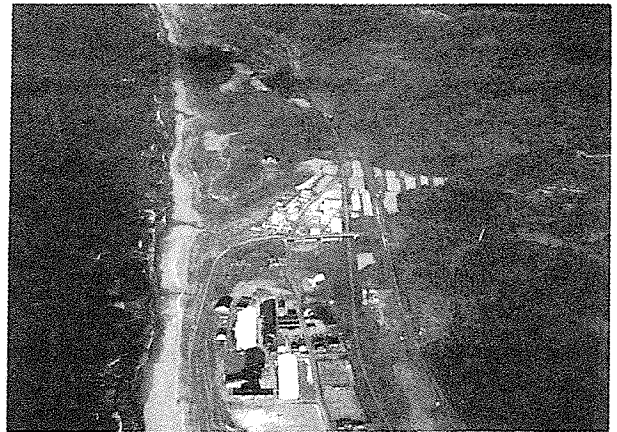
写真－3 仁賀保町より北側の海岸線を望む (撮影：秋田工事事務所、2002)
