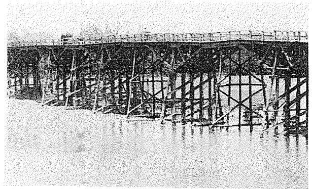
写真-18 熊本の豊水橋
