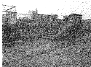
写真12 両国橋取付階段(東京) (筆者撮影)
